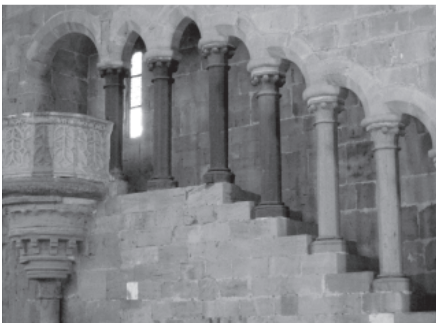
Detalle del púlpito que se encuentra en el refectorio.
