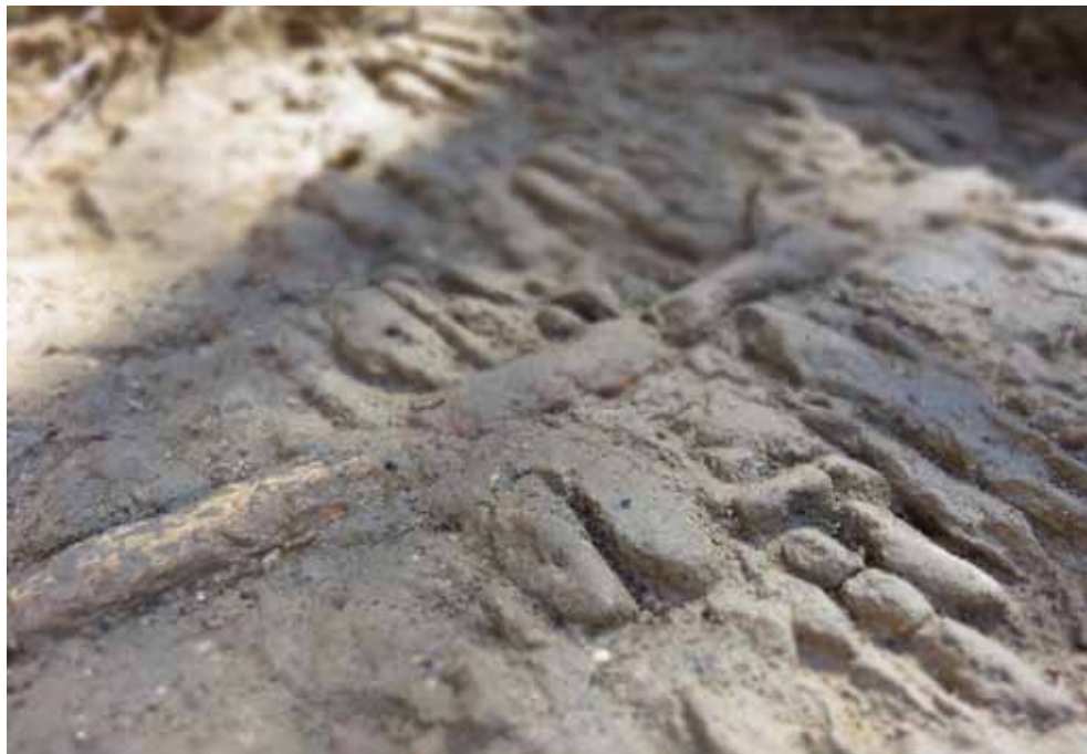
Fig. 6. Detalle del pavimento con el parteaguas (foto D. Bejarano)
