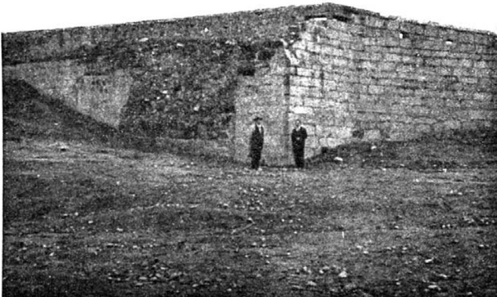
Fig. 4.- Arranque del puente de Medellín. En el centro, el núcleo de hormigón al descubierto (Fot. A. G. y B.)
