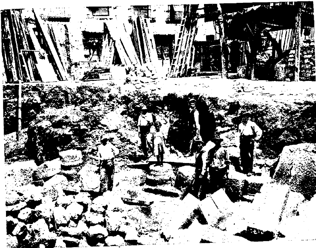
VISTA PARCIAL DEL SOLAR DE LA CASA DEL SR. MARTÍNEZ, DONDE SE APRECIA UNA PARTE DEL FÓRTICO
