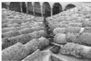
Testour. Sistema de evacuación de aguas pluviales sobre la terraza de la Grande Mosquée en 1984
