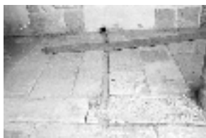
Testour. Sistema de evacuación del agua debajo del pórtico del patio de la Grande Mosquée en 1984
