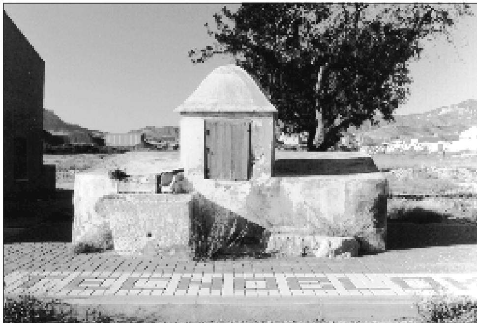
Foto 1. Aljibe de cisterna con cubierta plana e inclinada (proximidades del núcleo de Agost, Alicante).
